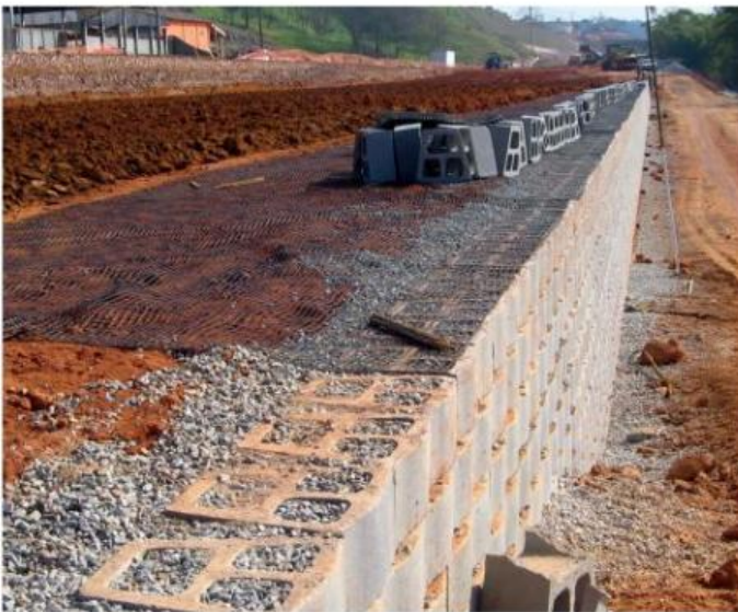
Aplicação de geogrelhas Fortrac em obras de Muros Terrae
