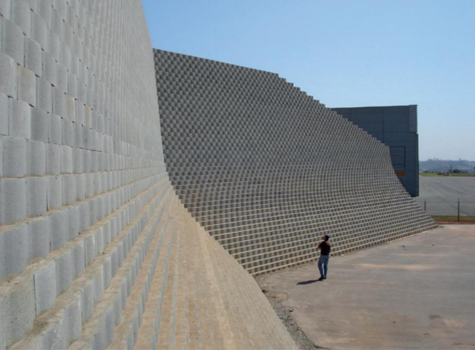
Barreira de Som no Aeroporto de Jundiaí (SP)
