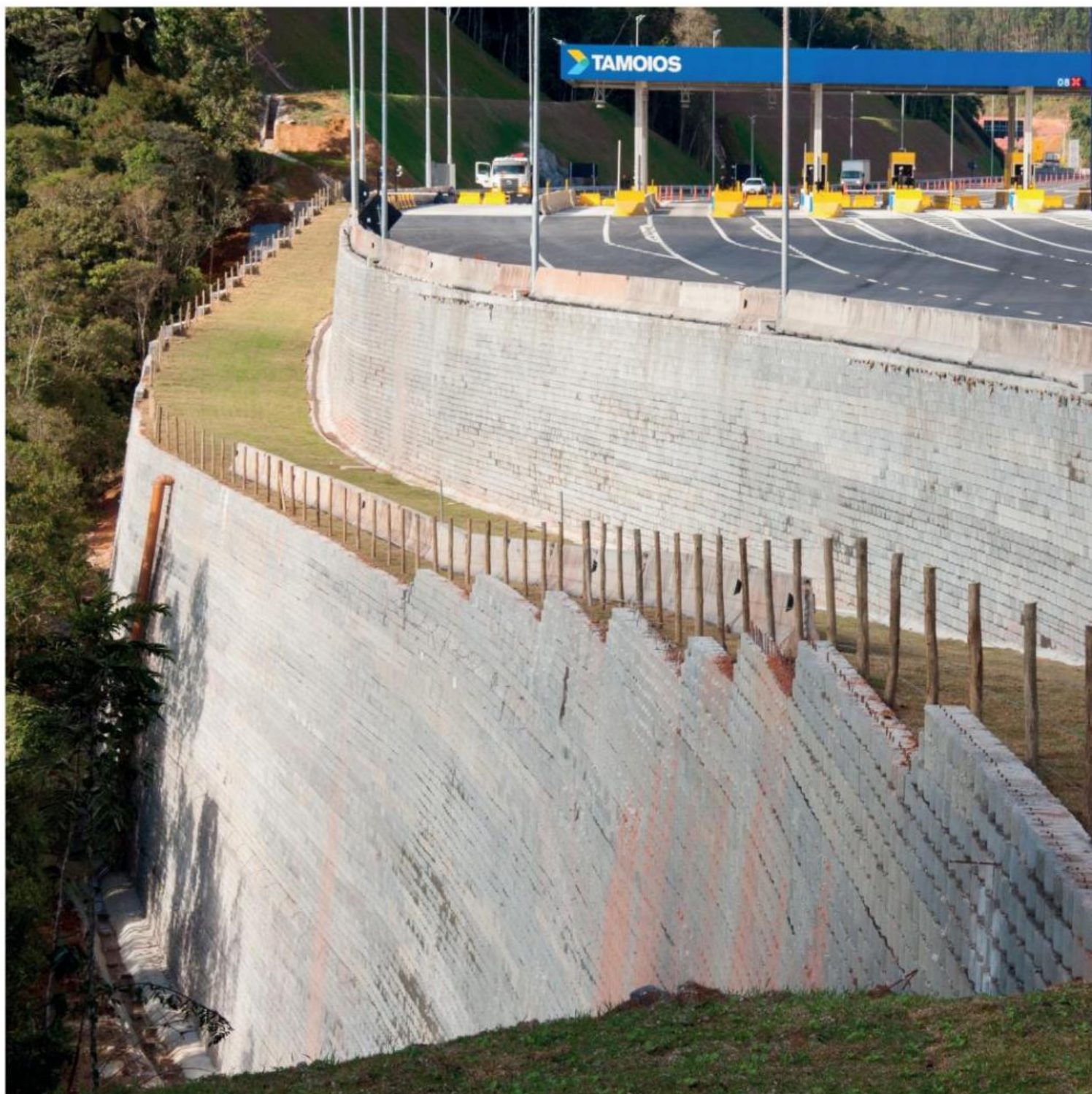
Muro Terra na Rodovia dos Tamoios (SP)
