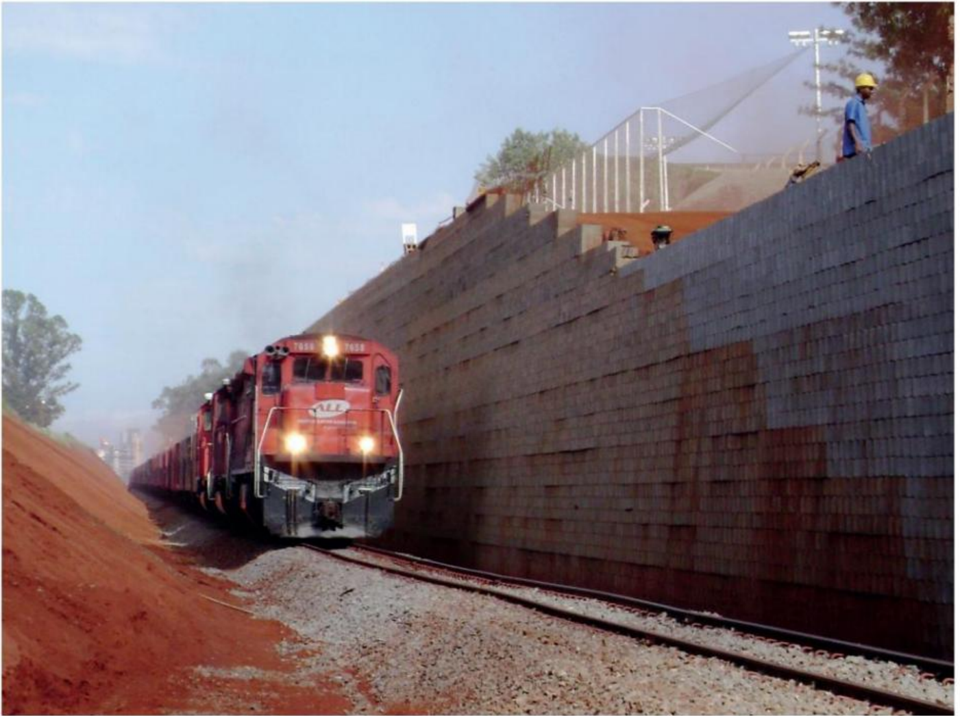
Muro Terrae executado em Maringá (PR)
